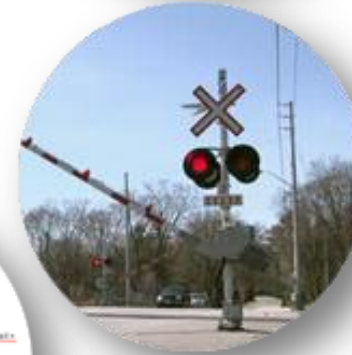
4. Góc chắn đường ngang thông minh
